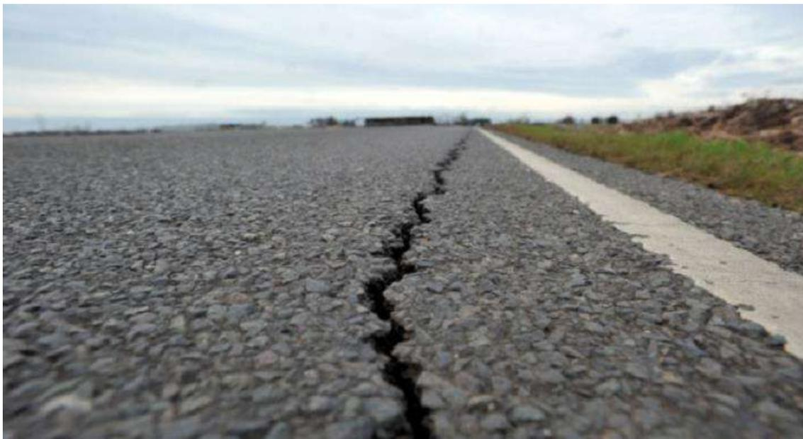
*Figura 13.* Fisura por reflexión de juntas
