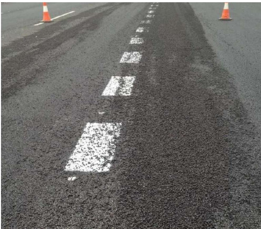
*Figura 17.* Desintegración por estrías longitudinales.
