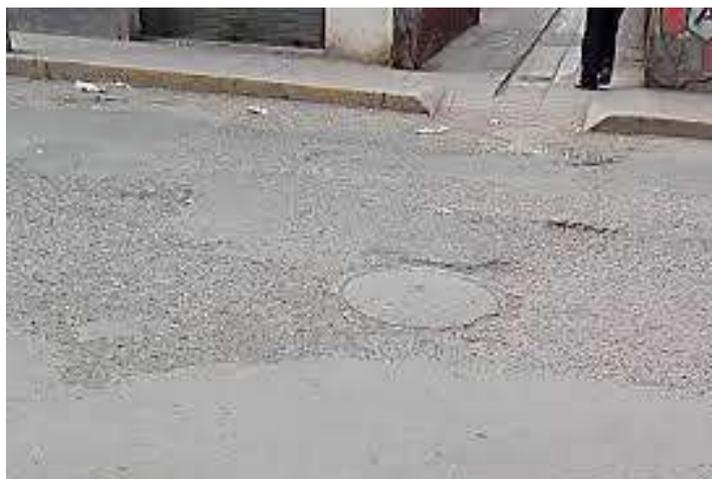
**Figura 16.** Desintegraciones por peladuras.
