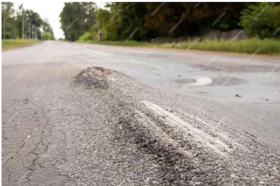
**Figura 18.** Desintegración por baches.
