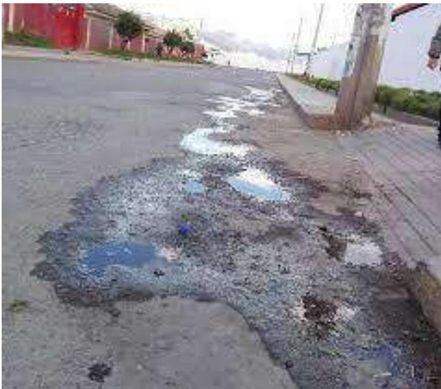
**Figura 15.** Desintegraciones por desprendimiento de agregados
