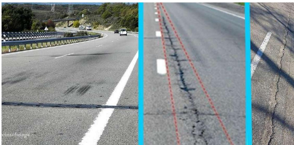
**Figura 10.** Fisura longitudinal
