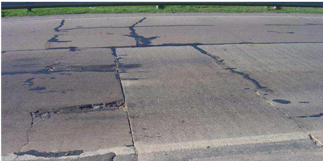
**Figura 9.** Fisura longitudinal
