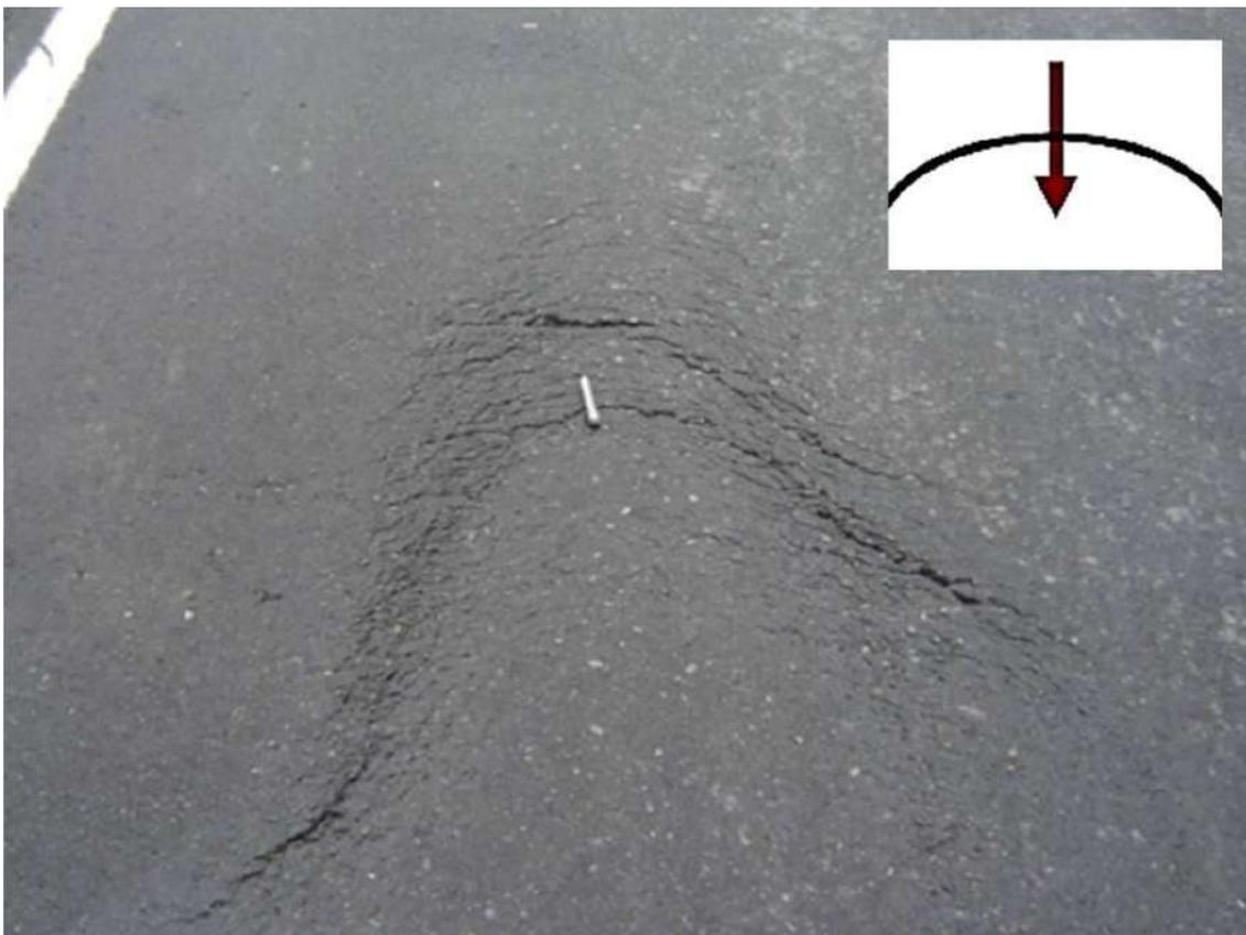
*Figura 14.* Fisura en arco
