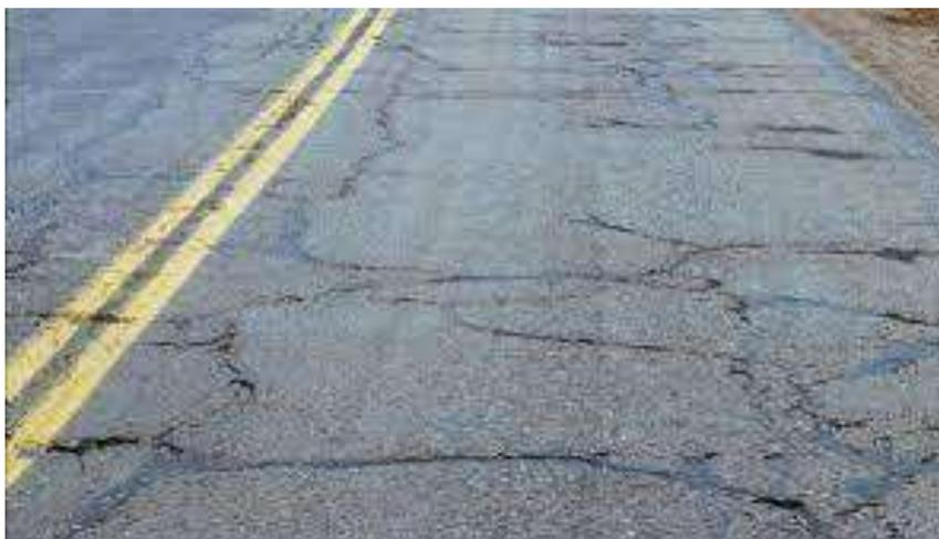
**Figura 11.** Fisura en bloques
