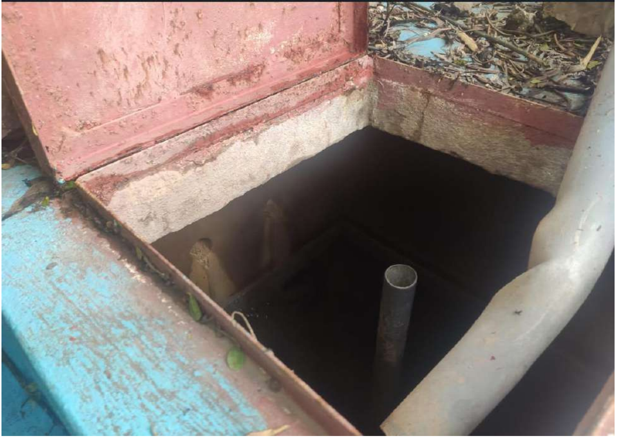
Fig. 9. Captación de agua
