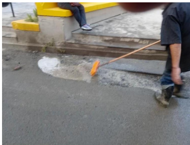
Figura 16 barrido del residuo liquido hacia la canaleta del desagüe
