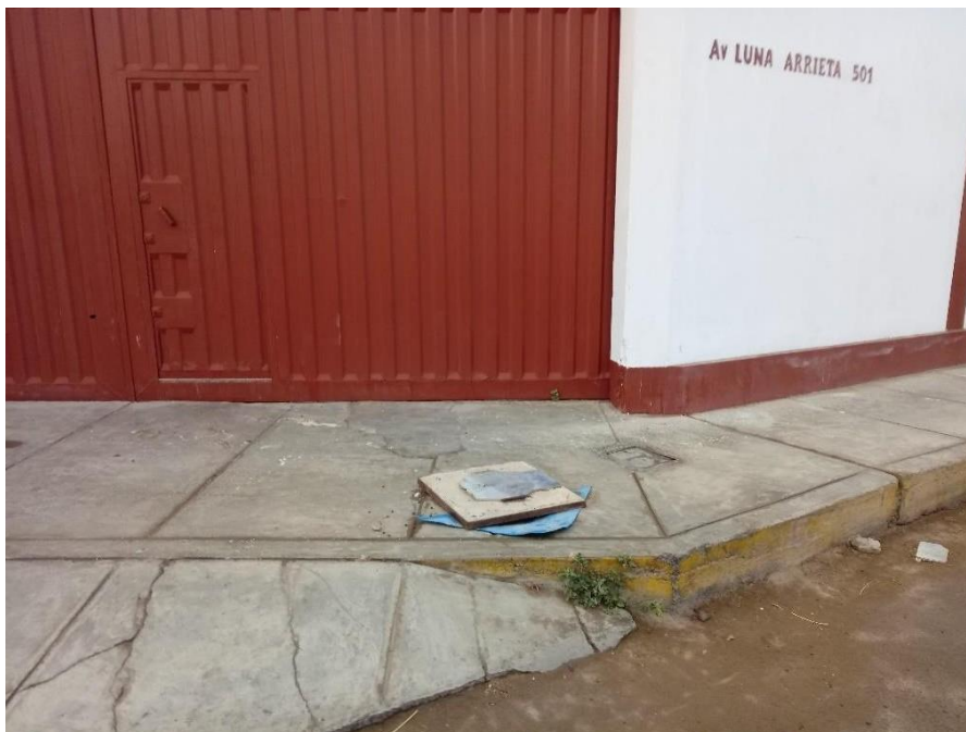
Figura 20 El desagüe de aguas servidas de fábrica de conservas industrial don Martín SAC.
