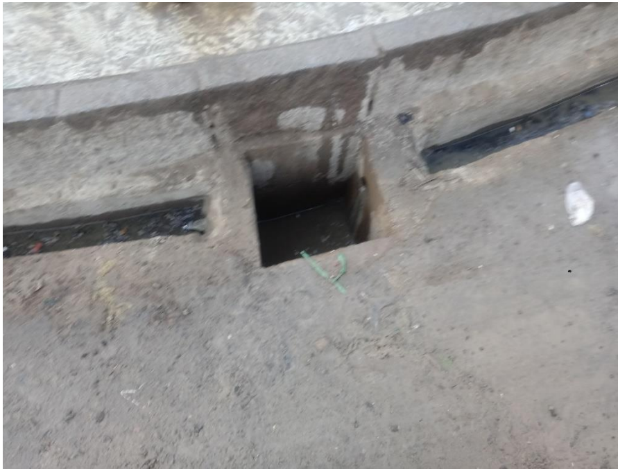
Figura 18 Desagüe de las canaletas hacia el colector publico del puerto de Huacho
