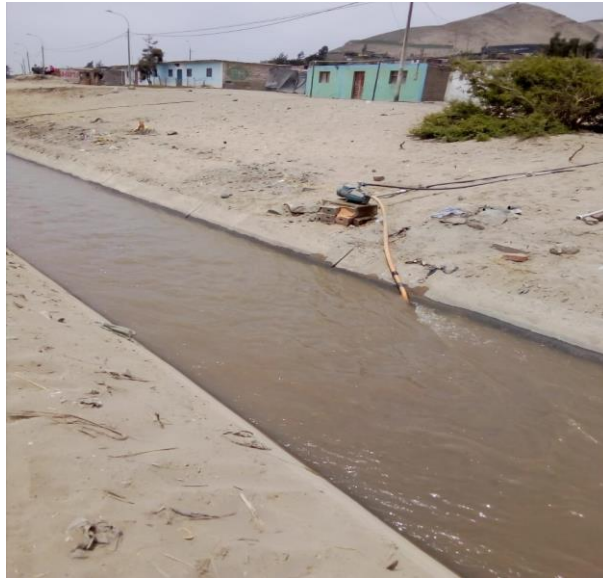
Figura 8 Canal del centro poblado Agropensa
