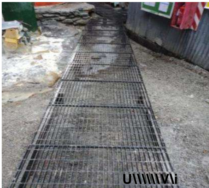
Foto N° 6: Pasadizo antideslizante colocado próximo a la sala de reactivos.
