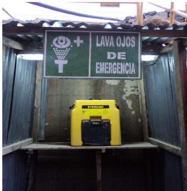
Foto N° 2: Para atenuar el contacto con sustancias químicas (reactivos) se ha dispuesto de lavaojos y duchas. En la vista se observa uno de los lava ojos.
