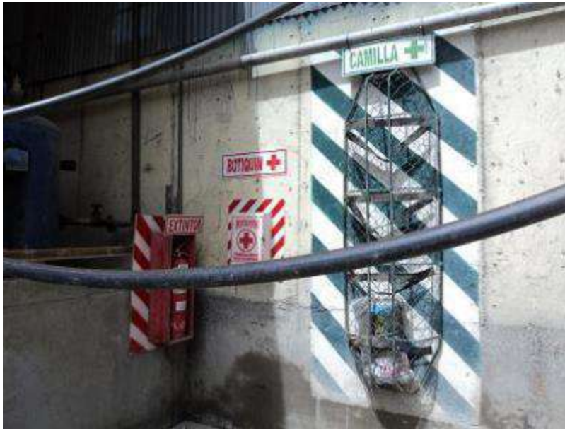
Foto Nº 1: Vista de la camilla, botiquín de primeros auxilios y extintor de P.Q.S. ubicado frente a la zona de filtro de prensa.
