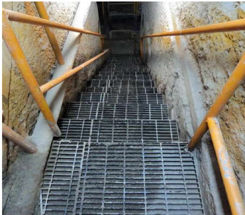
Foto Nº 8: Vista de una escalera donde se ha instalado piso antideslizante y barandas.
