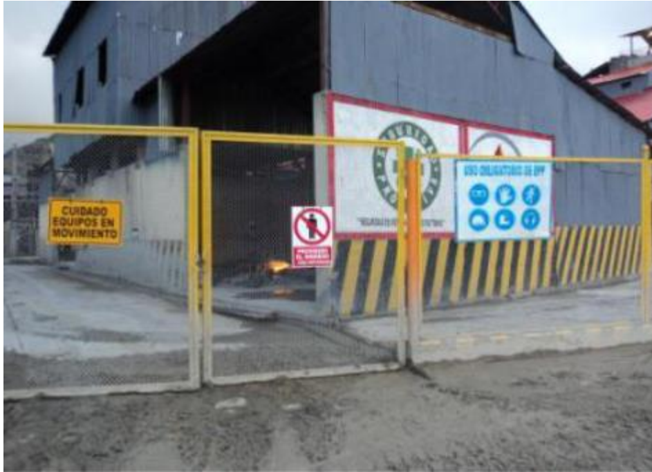
Foto N° 3: Señales preventivas, restrictivas y obligatoriedad ubicadas al ingreso a la planta concentradora, de acuerdo al código de colores anexo N° 11
