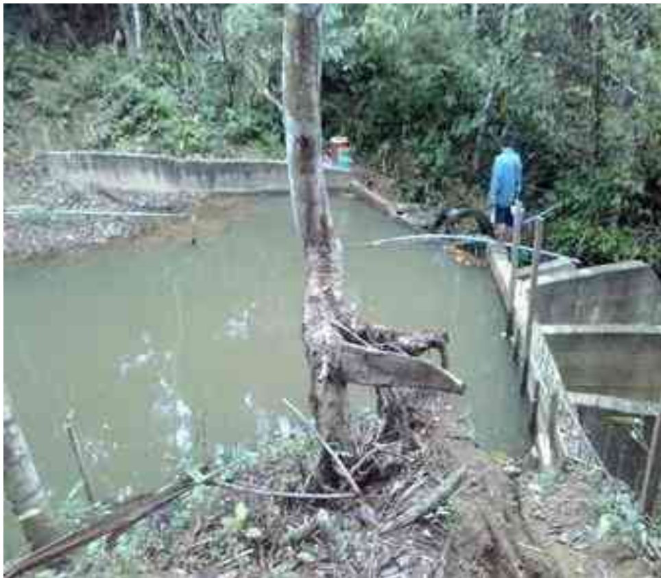
Figura 20: Tubería de impulsión desde la bomba con \varnothing 1" que empalma a una tubería de \varnothing 1 1/2"
