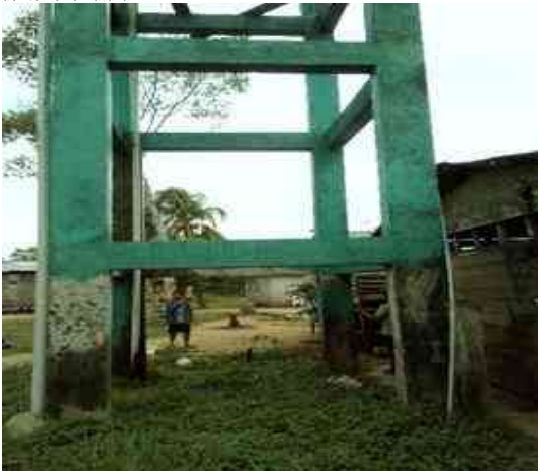
Figura 22: Tuberías de ingreso, salida y rebose.
