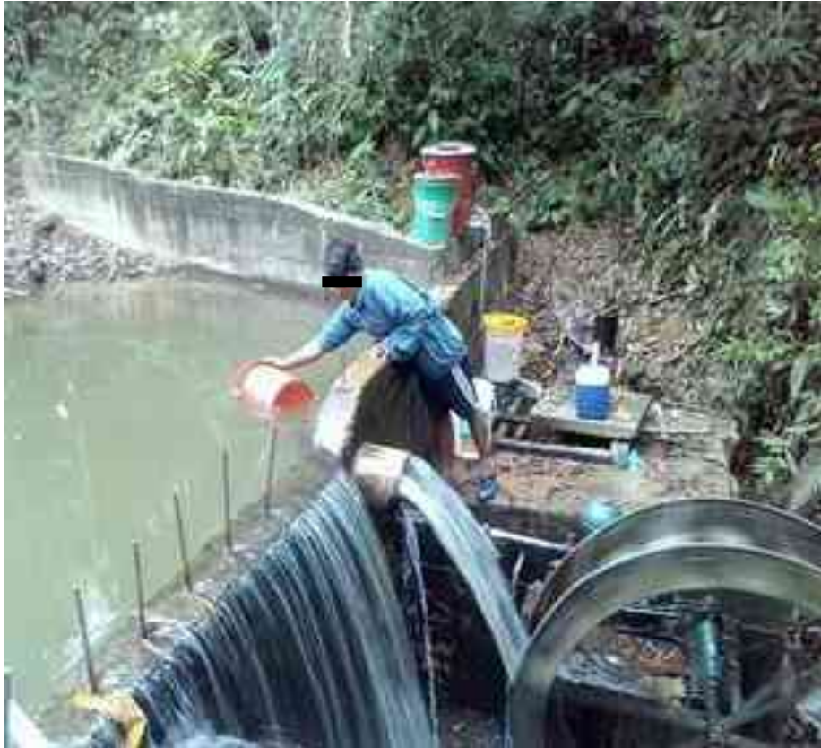
Figura 15: captación de agua superficial, se observa el agua de color marrón claro.
