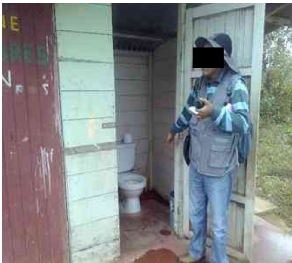
Figura 26: Caseta o cuarto de baño de madera con cobertura de calamina galvanizada
