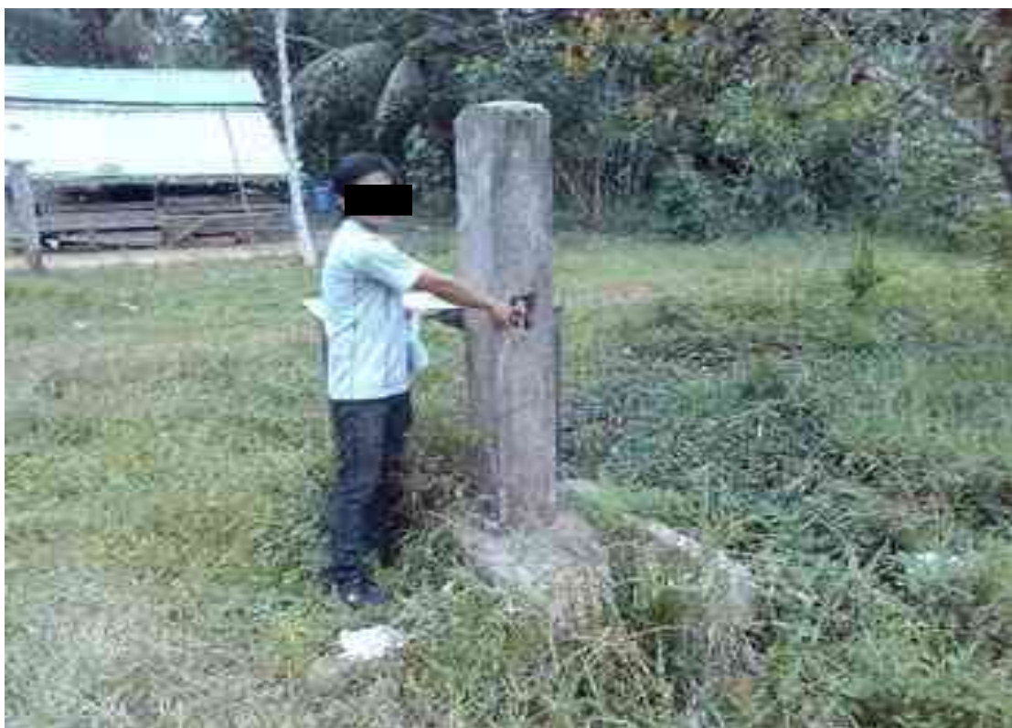
Figura 25: Las piletas no funcionan.
