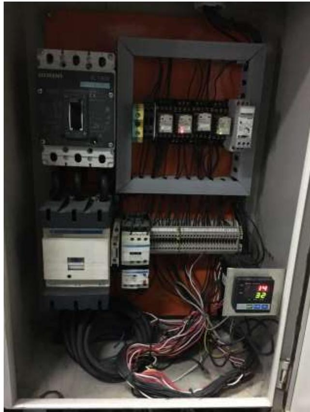
**FIGURA 22: ETAPA DE POTENCIA DEL ESTERILIZADOR
