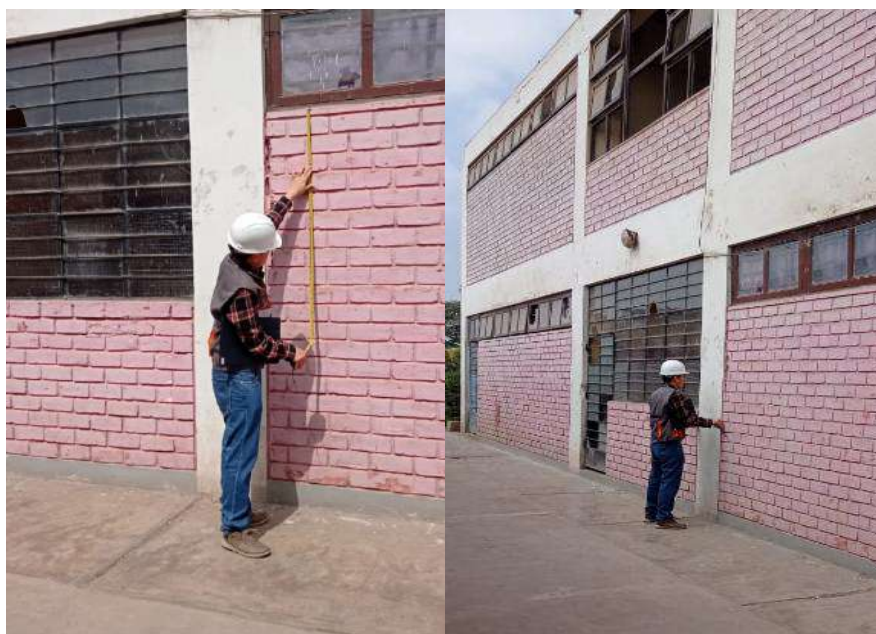
Figura 6. Fotografía de la estructura en evaluación.
