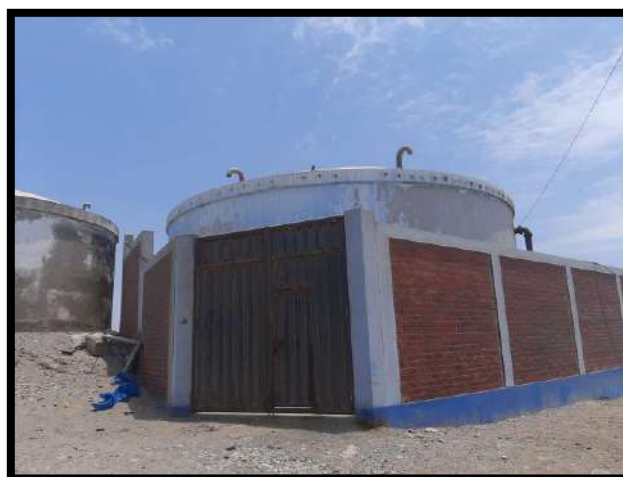
Figura 3. Reservorio Apoyado existente
