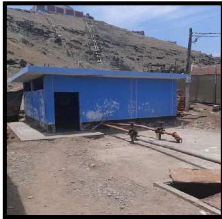
Figura 1. Caseta de Bombeo
